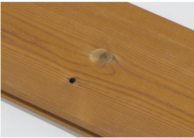
Dopuszczalne są drobne otwory po sękach na desce (nie przez całą grubość).
