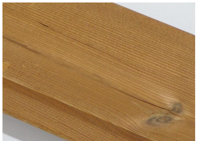
Dopuszczalne są nieznaczne pęknięcia na krawędziach.
