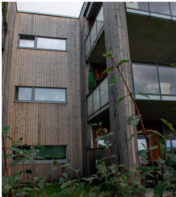
Budynek mieszkalny w Norwegii. Elewacja z Thermory thermo-sosny kilka lat po montażu. Zdjęcie - Thermory.
