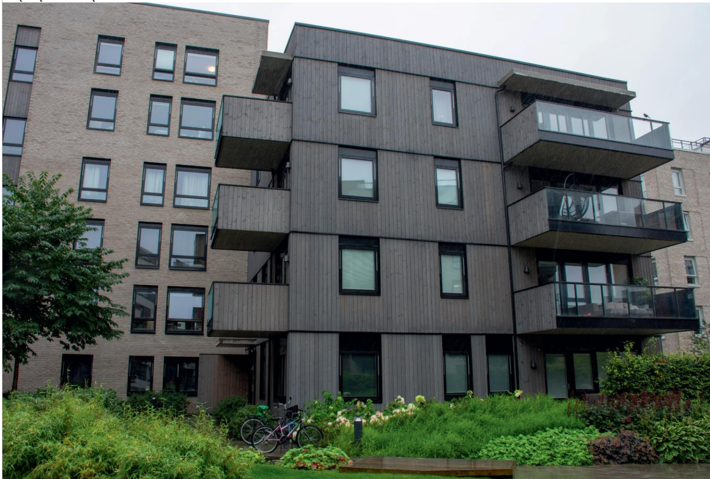
Blok mieszkalny w Norwegii. Elewacja Vivid Silvered Shield po 6 latach od montażu. Dystrybutor: Moelven. Zdjęcie Thermory.
