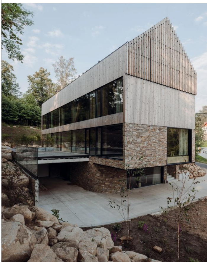
Elewacja z Thermory thermo-sosny, bez olejowania, rok po montażu. Apartamentowiec w Polsce. Dystrybucja i zdjęcie: Komplex Market.
